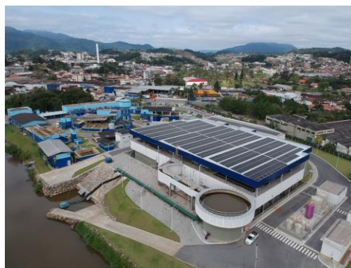
Figura 16 - ETA Central – Vista Superior.
