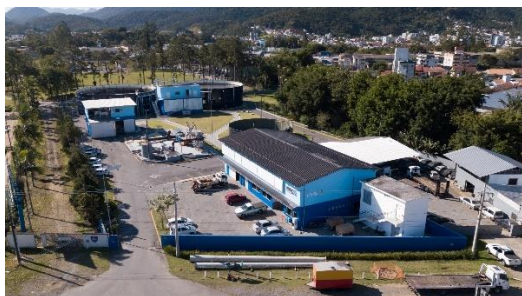
Figura 36 - Vista geral da Nova ETE Água Verde.
