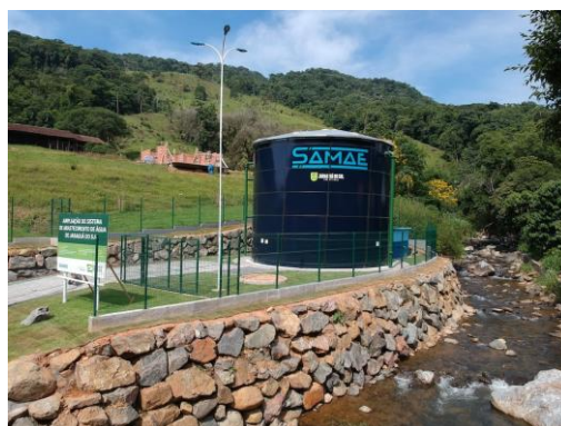
Figura 24 - Reservatório Intermediário Rio Molha.
