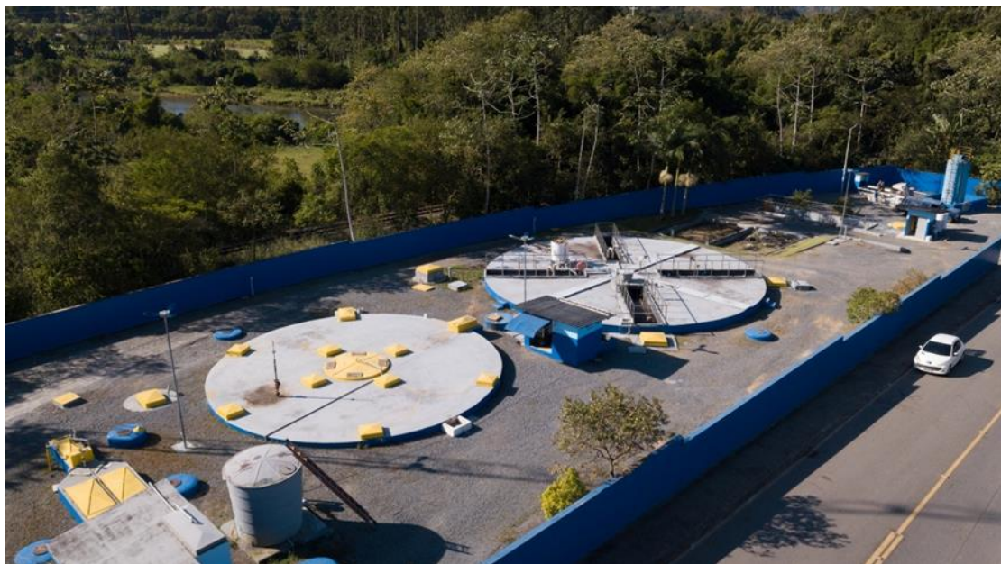
Figura 39 - Vista geral ETE Nereu Ramos.
