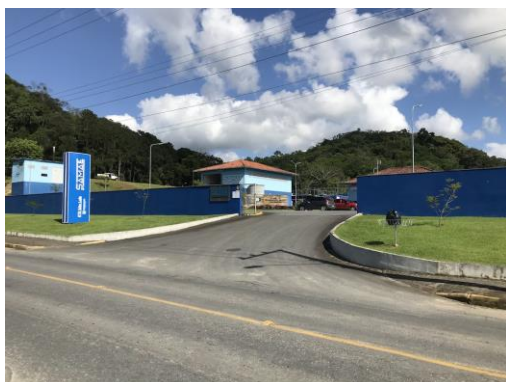
Figura 34 - ETE São Luis – Vista frontal.
