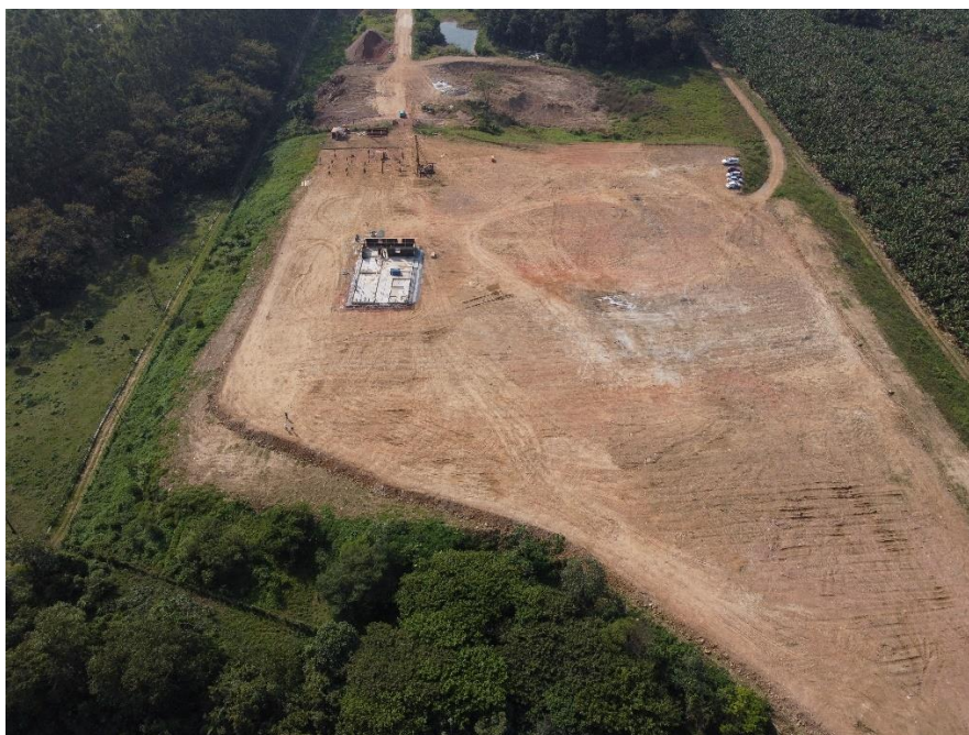
Figura 47 - Imagem aérea da construção da nova estação.
