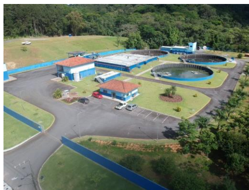
Figura 35 - ETE São Luis - Vista geral.
