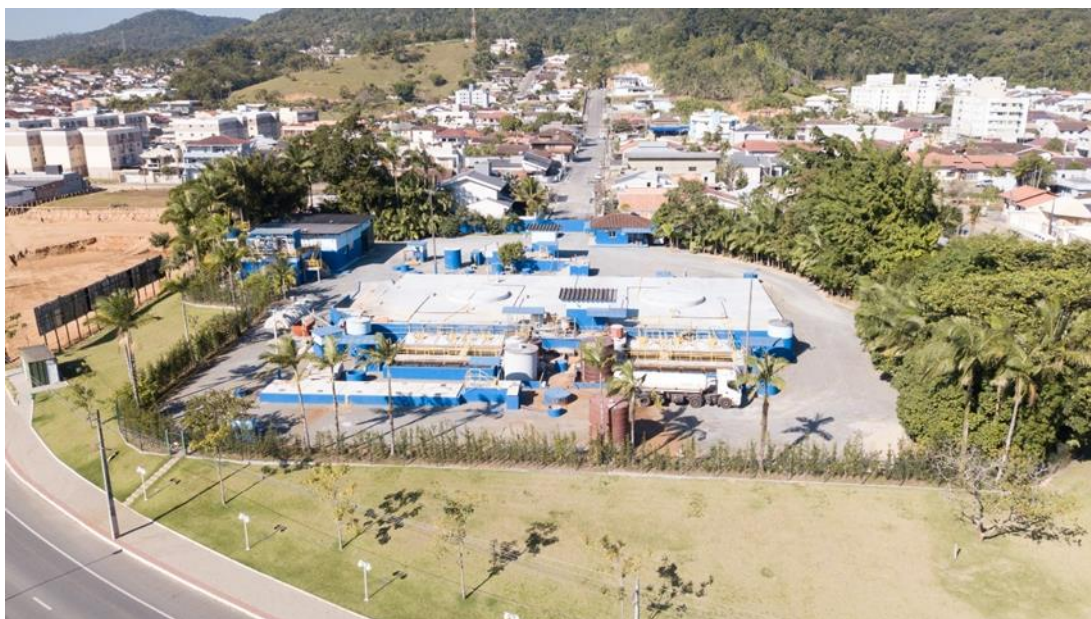
Figura 38 - Vista geral ETE Figueira.
