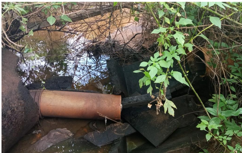
Imagem 05 – Entulhos da rede desativada do emissário existente
