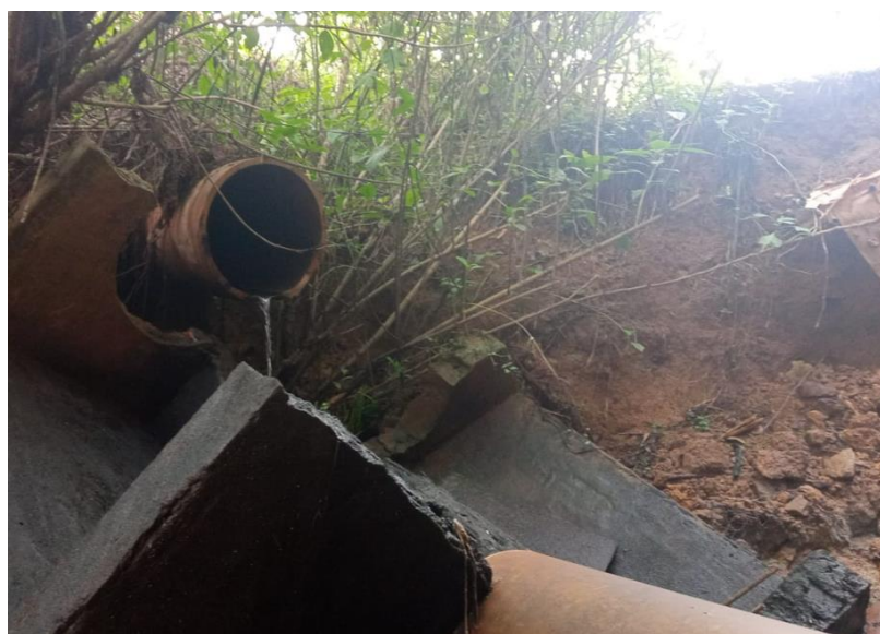
Imagem 06 – Entulhos da rede desativada do emissário existente 02
