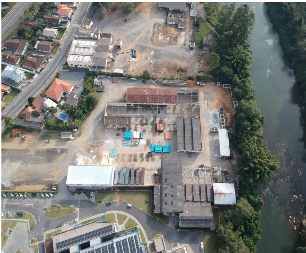
Imagem 02 - Foto aérea para visualização do atual estado das edificações.
