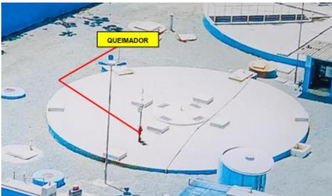
Imagem 03 - Tubulações a serem instaladas e o posicionamento do sistema de queima de biogás.
