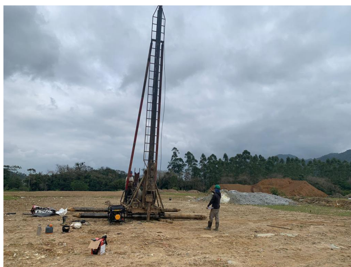
Foto 2: Cravação estaca metálica TR 45
