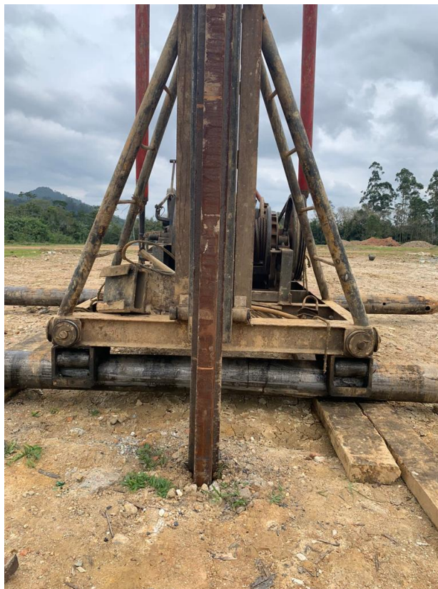
Foto1: Cravação estaca METÁLICA TR 45
