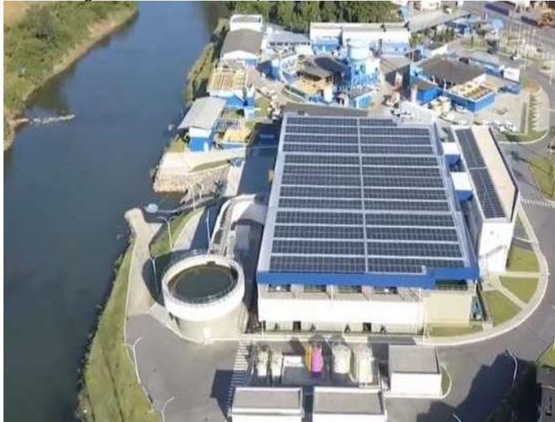
Figura 60. ETA Central e painéis fotovoltaicos instalados.
