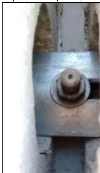
Figura 3. Processo de fixação entre dois painéis pré-fabricados alveolares.
