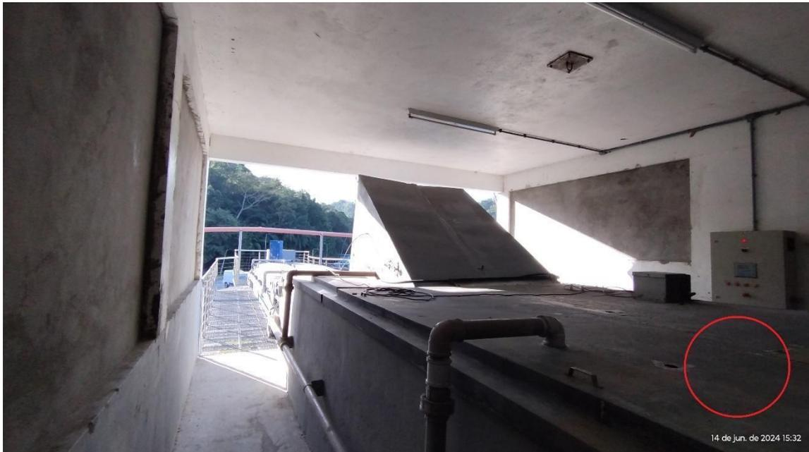
Imagem 06 – Local de instalação de sistema de sucção de H<sub>2</sub>S na tampa do canal de entrada.
