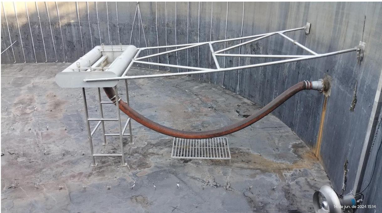
Imagem 13 – Vertedor flutuante atual instalado nos reatores.
