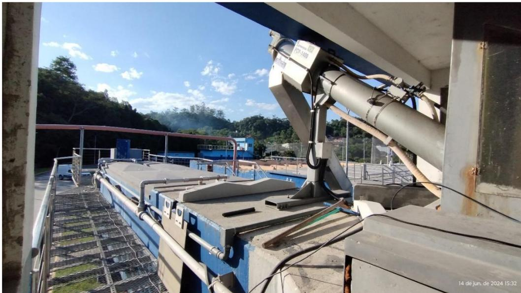
Imagem 05 – Sistema do canal de entrada da estação de tratamento.
