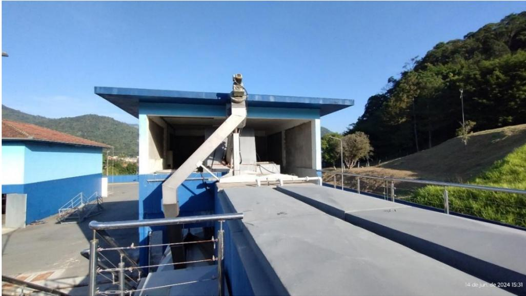
Imagem 04 – Sistema do canal de entrada da estação de tratamento.
