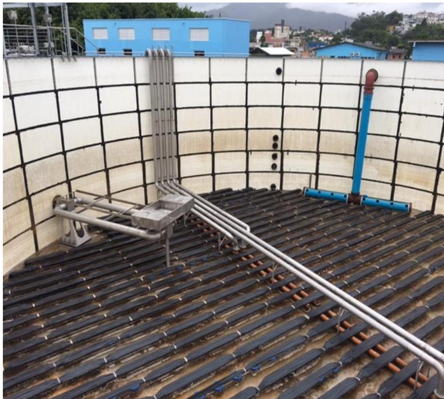
Imagem 16 – Vertedor com sistema de cabos e polias instalado na ETE Água Verde utilizado como referência para este projeto (Referência: Projeto executivo, fornecimento e instalação pela empresa Rotária do Brasil).
