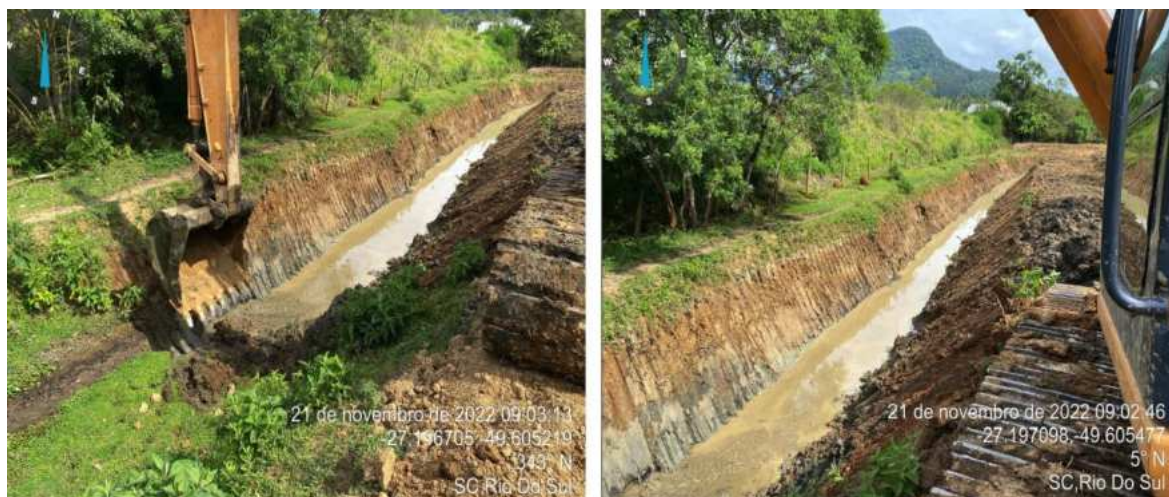
Figura 34 – Registro fotográfico do serviço de desassoreamento de cursos d'água
