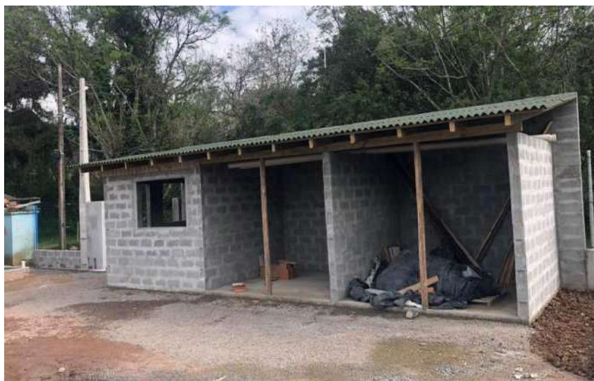
Figura 27 – Local para acondicionamento de serragem, galões e adubo
