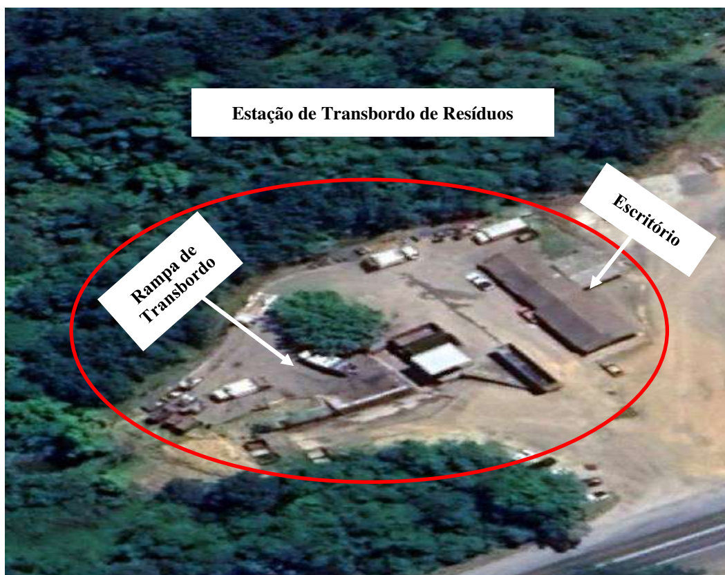
Figura 13 - Vista geral da Estação de Transbordo
