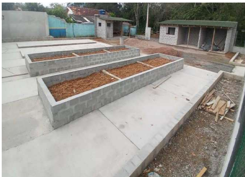
Figura 25 – Leiras de compostagem ao lado dos canteiros no espaço da Horta Comunitária
