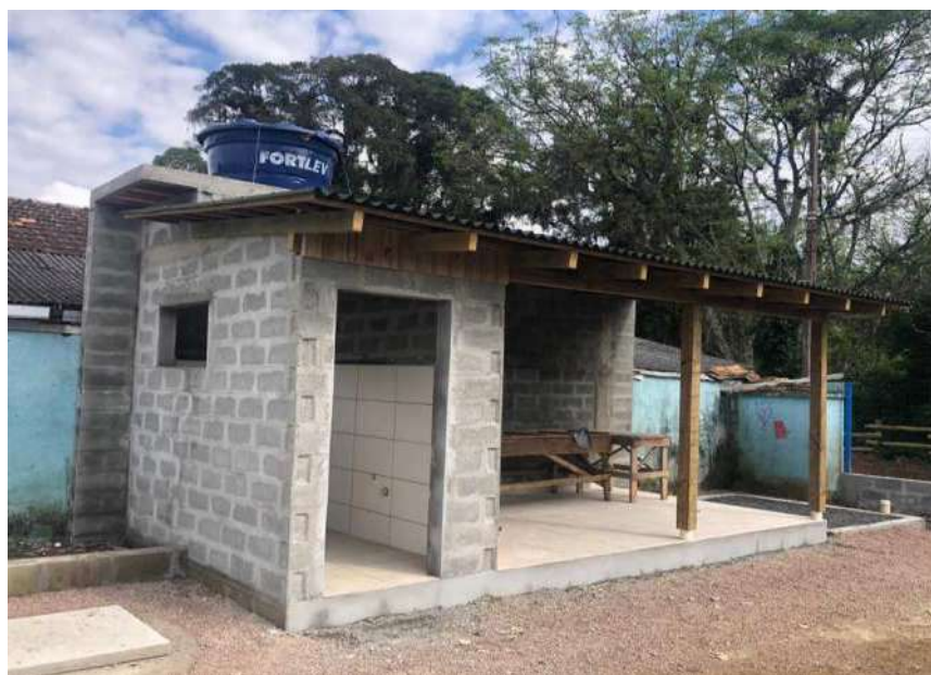
Figura 24 –Edificação destinada para banheiro e ponto de água para irrigação dos canteiros.
