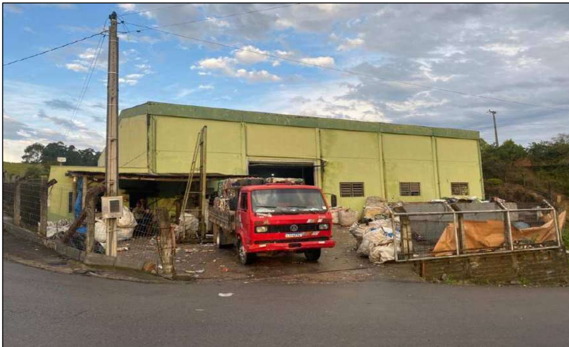
Figura 20 – Galpão da Cooperativa de Rio do Sul
