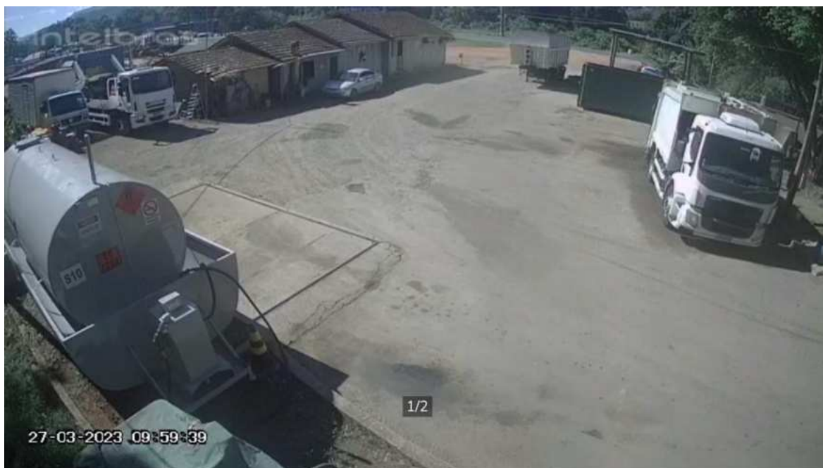
Figura 16 - Registro fotográfico da câmera instalada na Estação de Transbordo.
