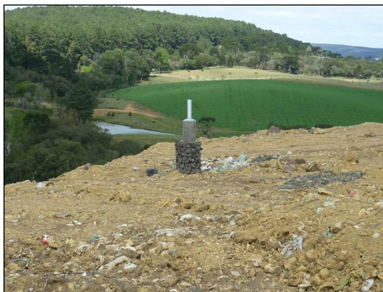
Figura 15: Sistema de Drenagem dos Gases (Setembro de 2010).
