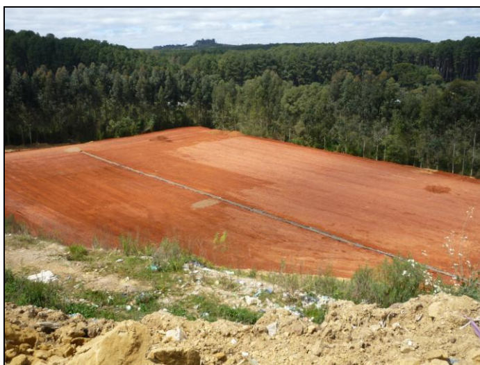
Figura 12: Impermeabilização da Base do Aterro com Argila Compactada (Setembro de 2010).
