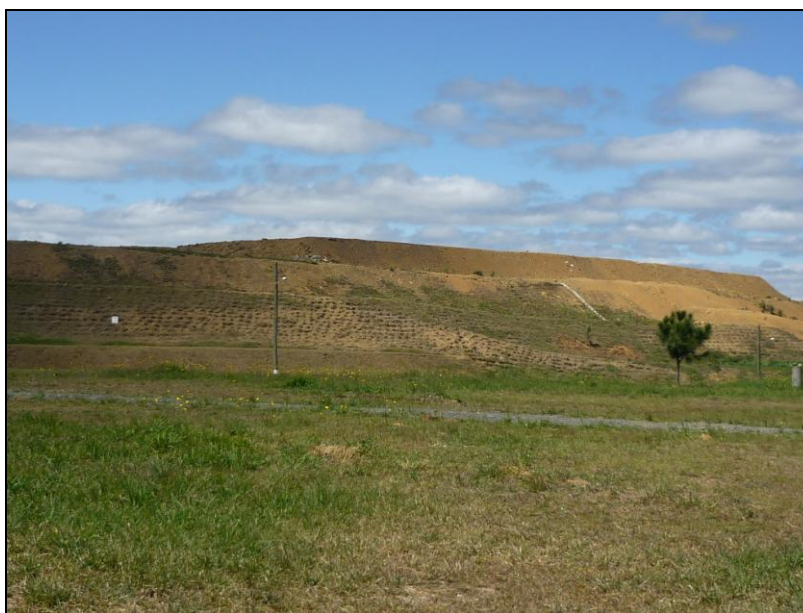
Figura 14: Célula Após Cobertura e Plantio de Vegetação (Setembro de 2010).
