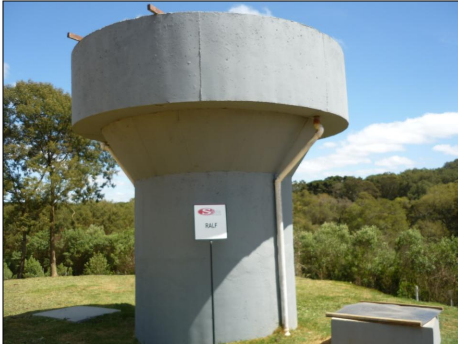
Figura 18: Reator Anaeróbio RALF (Setembro de 2010).
