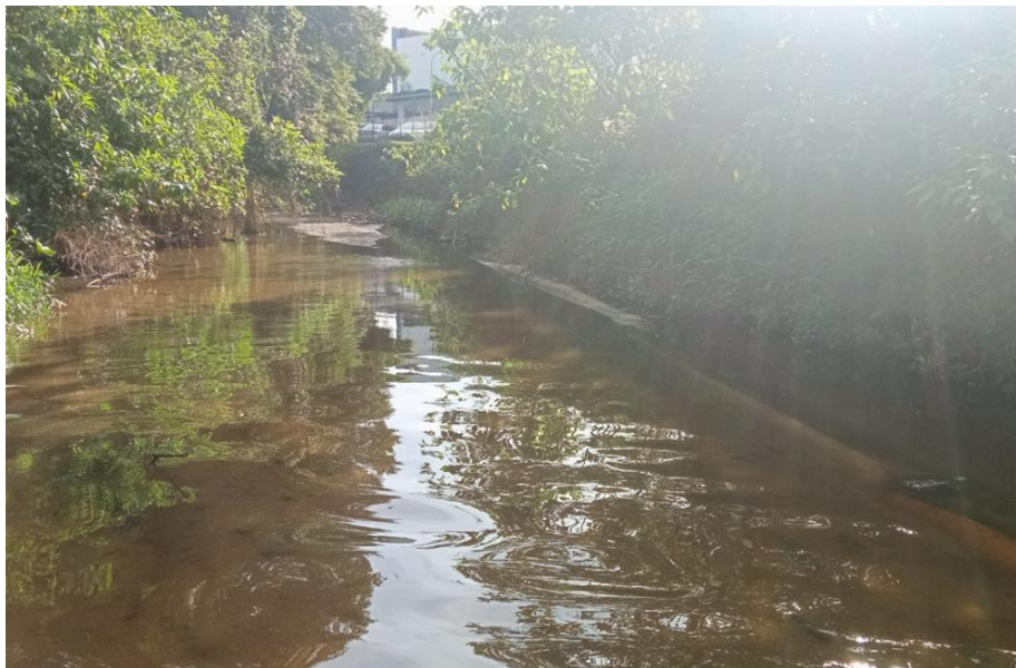
Imagem 03 - Canal entre galeria e ponto de lançamento no rio Itapocu
