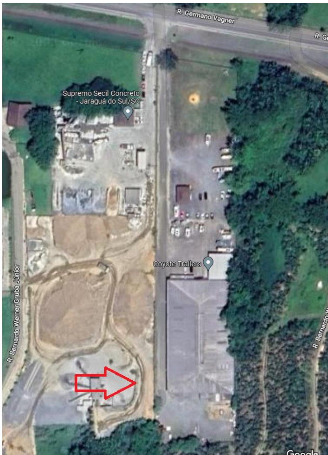
Imagem 03 – Posicionamento da rampa de acesso ao britador do antigo proprietário.
