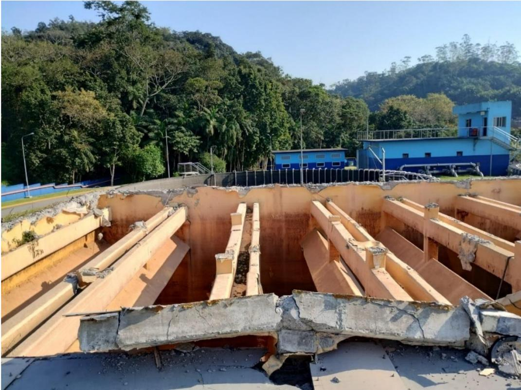
Imagem 05 – Partes da estrutura a serem demolidas ainda presas nas estruturas existentes.
