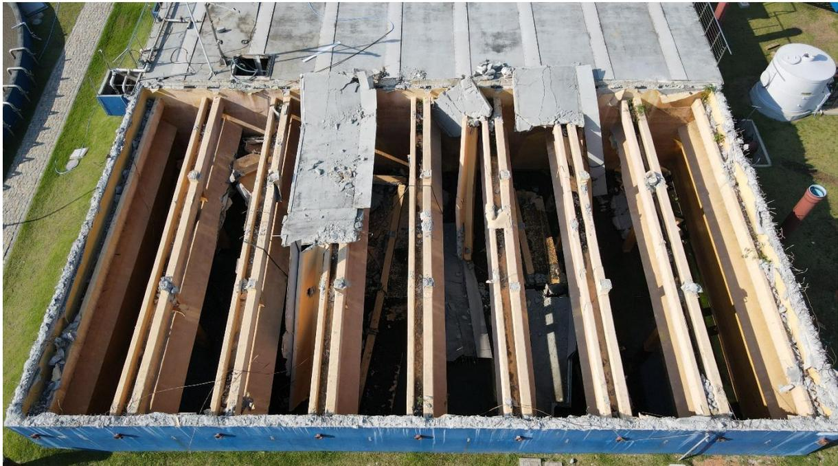
Imagem 03 – Estrutura da laje no fundo da edificação.
