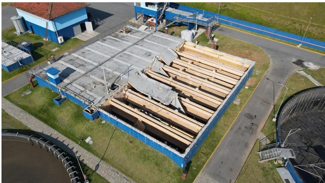
Imagem 02 – Estrutura que sofreu com sinistro de explosão de gases na estação.
